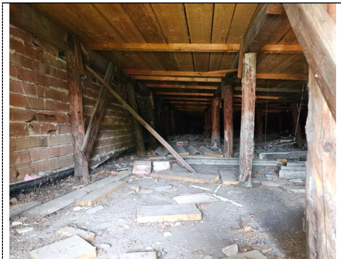
Obr. 2 Nosná konstrukce pultové střechy severního křídla MŠ [P1]
