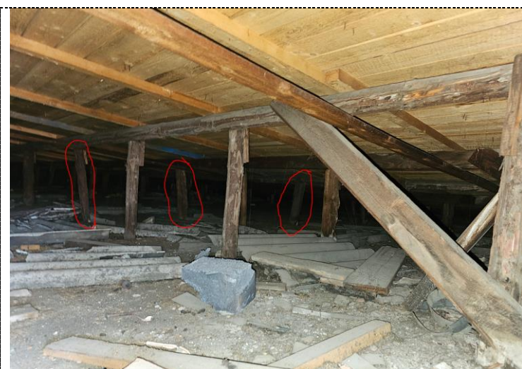
Obr. 3 Nosná konstrukce pultové střechy severního křídla MŠ šikmé sloupy [P1]
