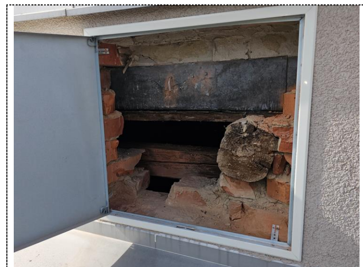
Obr. 4 Zhotovený revizní otvor po urgenci, že do původního nelze vzhledem ke svým rozměrům využít [P1]
