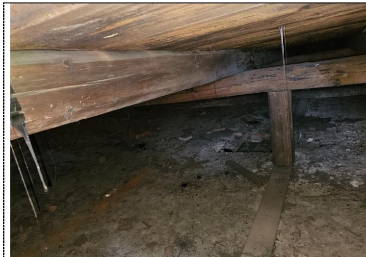
Obr. 5 Nosná konstrukce pultové střechy prostředního křídla MŠ [P1]
